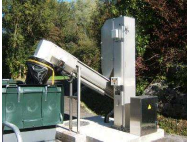
Dégrilleur automatique avec ensacheur
