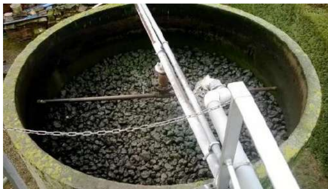
Vues de la station d'épuration de Bioule et son lit bactérien
